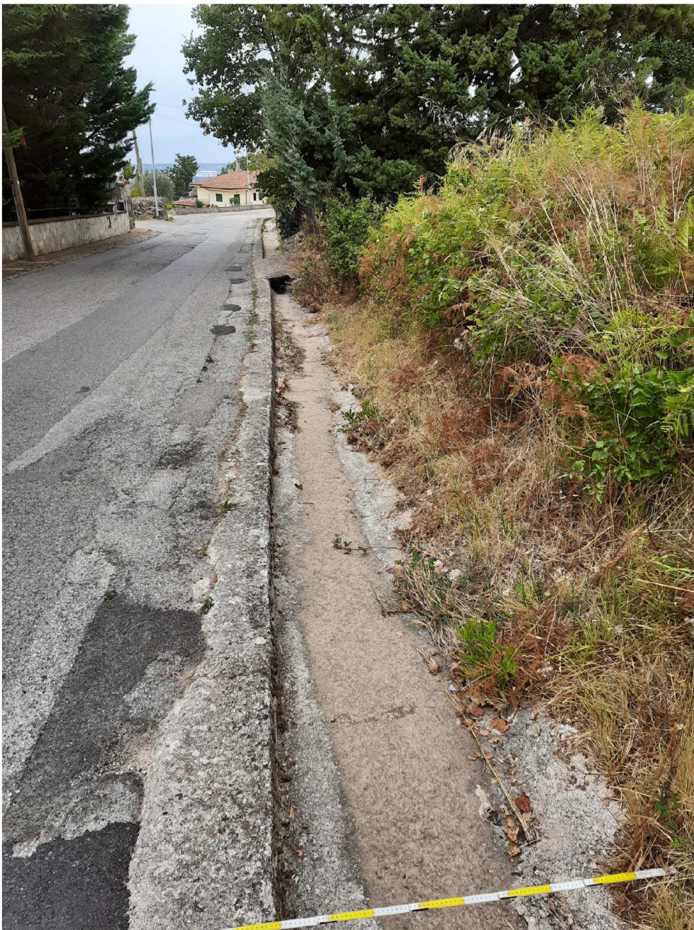
Foto 3 del Tratto GH con particolare del canale acque meteoriche di sezione insufficiente rispetto alle quantità da convogliare
